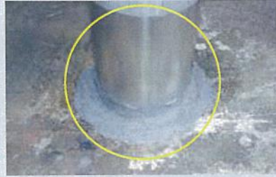
鋼製支柱地際
